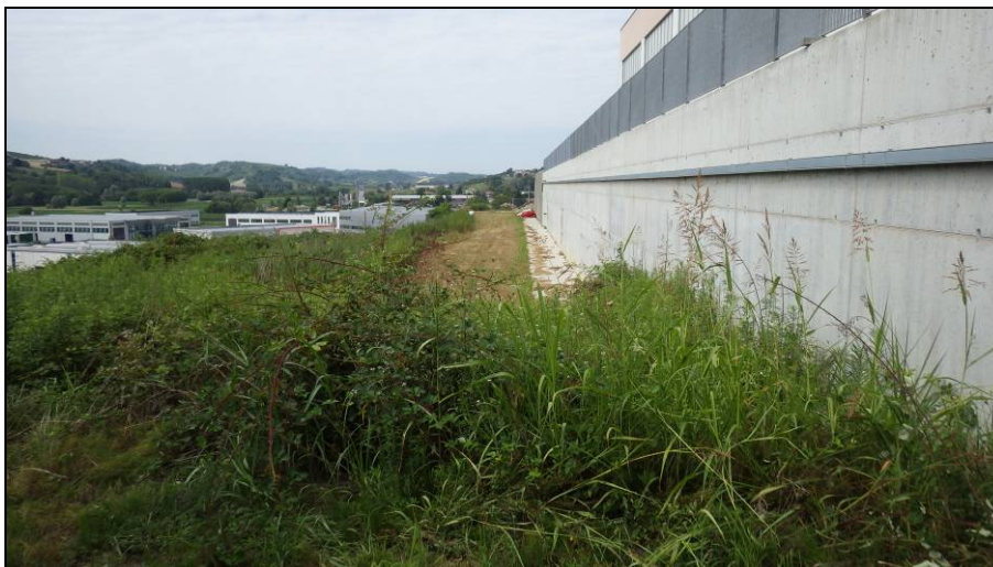
Fascia pianeggiante ribassata antistante lo stabilimento Rey esistente, ripresa da NE
