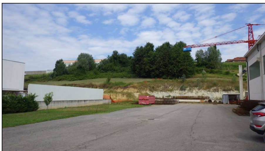
Scarpate di sbancamento approfondite al piede del pendio in esame per l'arretramento dei piazzali industriali posti nel fondovalle
