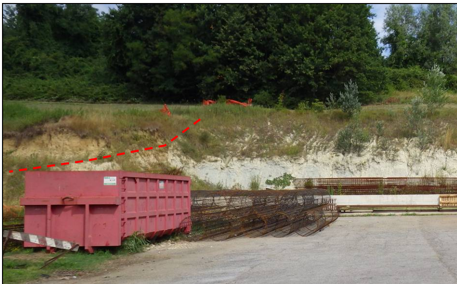
Affioramenti lungo le scarpate di sbancamento circostanti il piazzale industriale posto a valle dell'estremità NE del comparto di variante. Si osservano i terreni del substrato con sovrastanti depositi alluvionali di fondovalle, il cui limite è indicato in rosso
